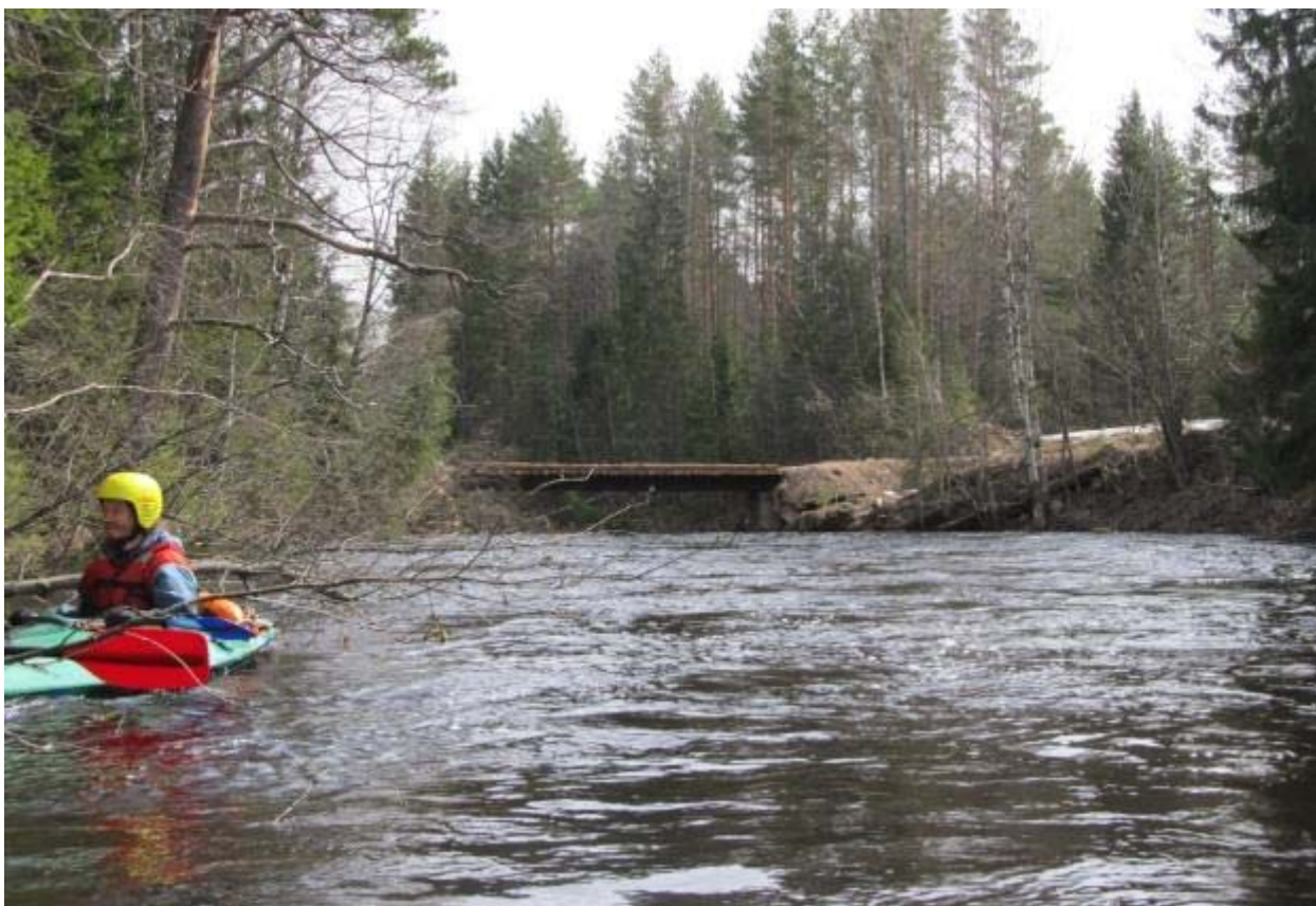
Фото 23 – Деревянный мост П15
