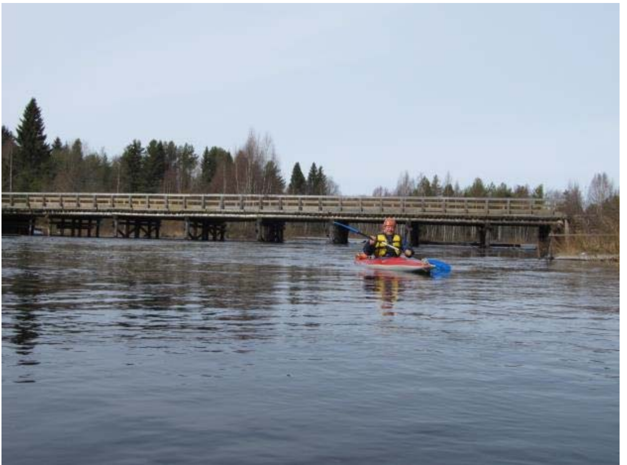
Фото 22 – Мост в д. Большие Горы
