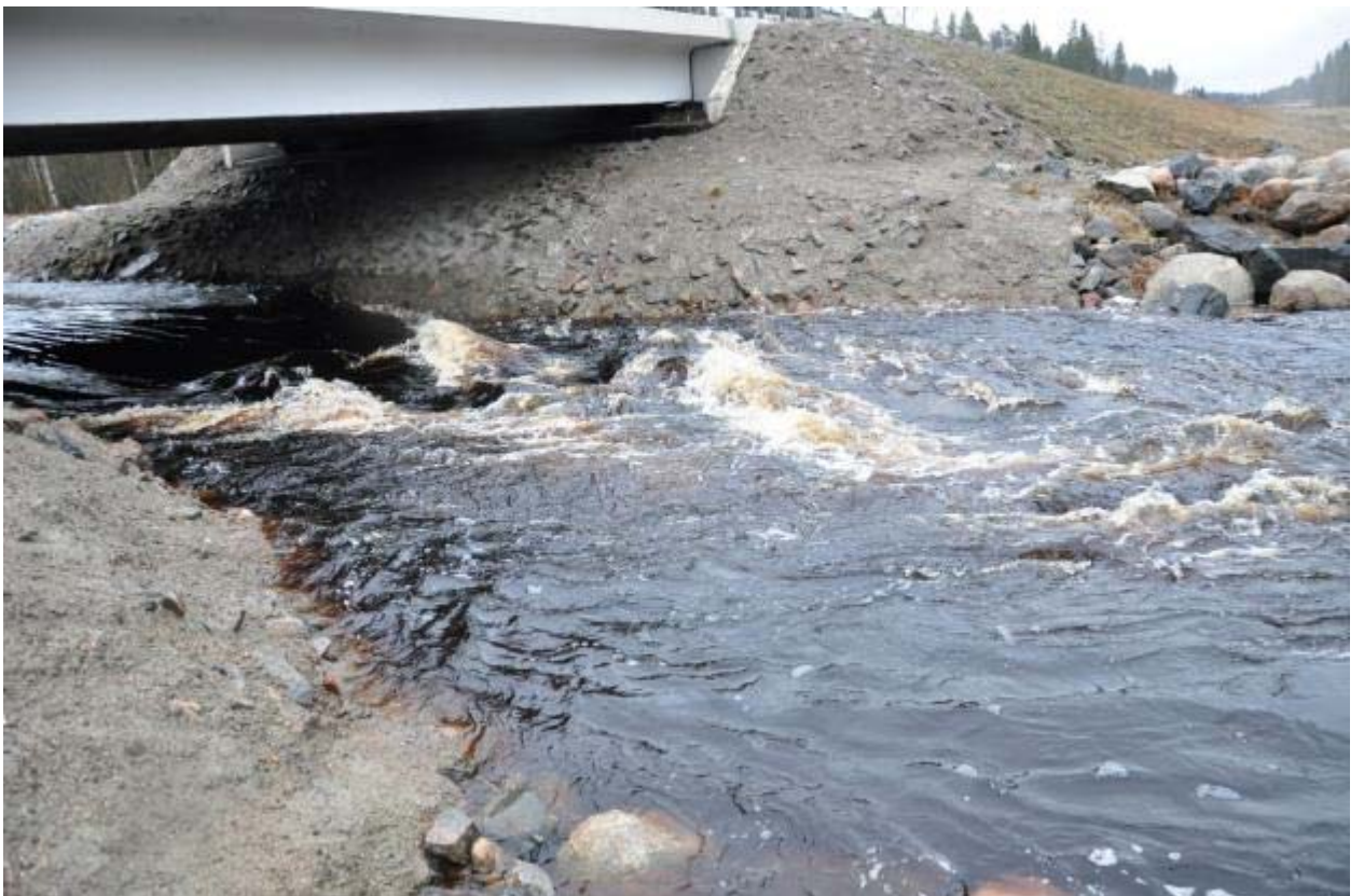
Фото 10 – Порог под мостом через реку Нялма.
